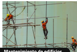
Mantenimiento de edificios.
