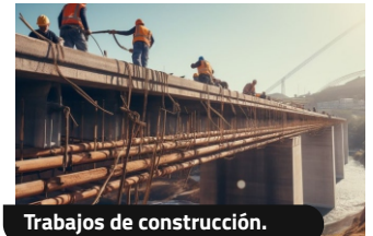
Trabajos de construcción.
