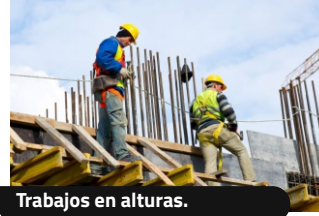
Trabajos en alturas.
